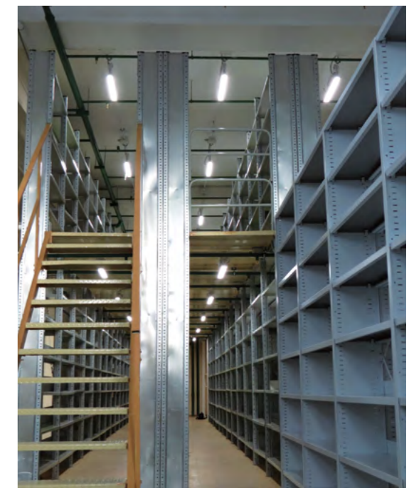
Освещение стеллажного хранилища «Учебно-Научной библиотеки УДГУ», Ижевск. В проекте применялись светодиодные светильники «ЭЙФЕЛЬ»
